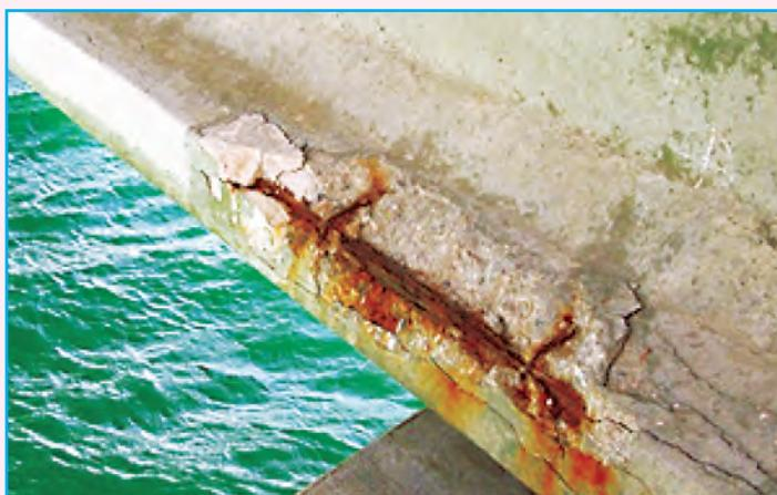
**Рисунок 2.** Коррозия арматуры в бетоне
