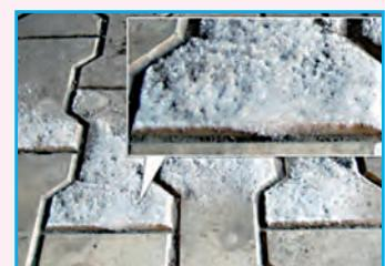
**Рисунок 3.** Высолообразование – белых налетов на поверхности в бетоне
